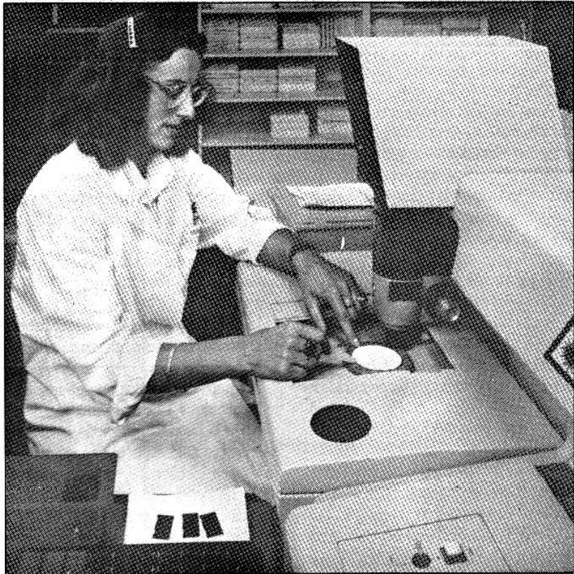
FABRICACION DE CELDAS SOLARES PARA APLICACIONES ESPACIALES; las celdas de 2 X 6 cm 2 Y 2 X 4 cm 2 son cortadas por rayo laser
